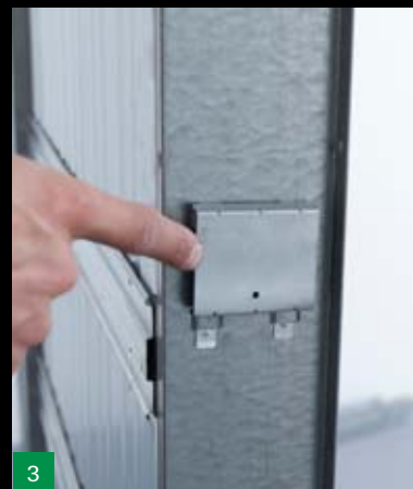
Kotevní místo pro SDK profil stavebního pouzdra
