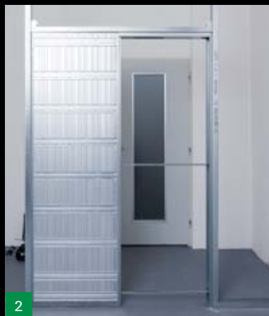
Usazení pouzdra do spodního profilu SDK
