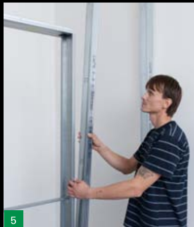
Montáž protilehlé strany SDK konstrukce
