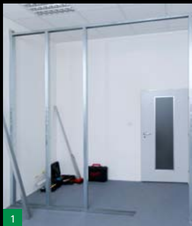
Příprava profilů SDK pro usazení pouzdra
