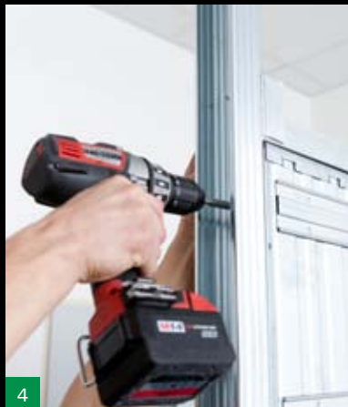
Připevnění pouzdra ke konstrukci SDK
