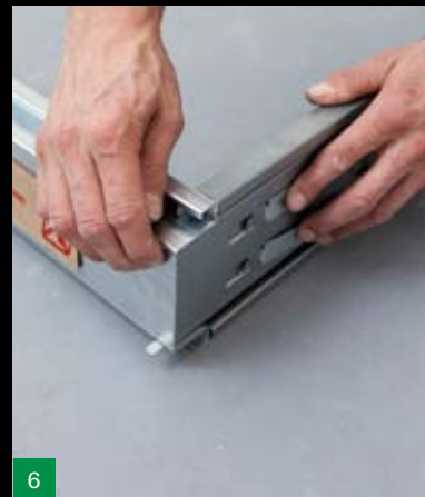
3 Vložte kolejnici s nadpražím do horní části pouzdra
